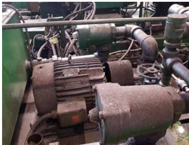
Slika 7 : Filtri postrojenja za valjanje pločevine v SIJ Acroni, d. o. o.
