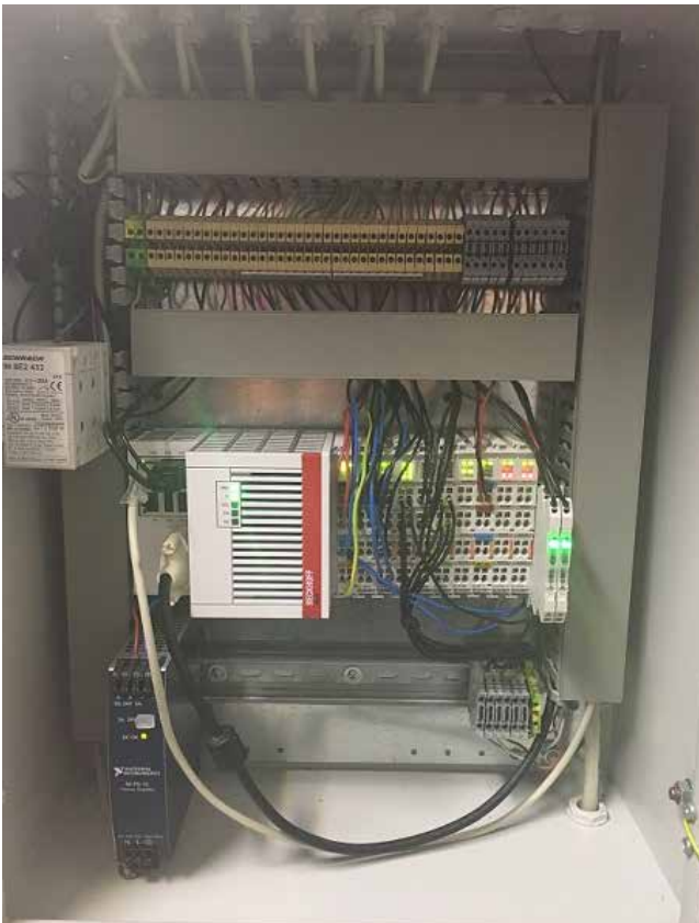
Slika 5 : Krmilnik Beckhoff CX5140 z vhodno-izhodnimi moduli
